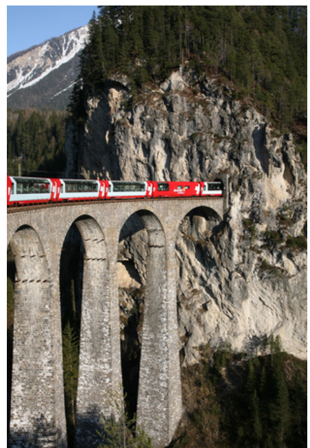
Wiadukt Landwasser, fot. Daniel Schewn (CC BY-SA 2.5)
