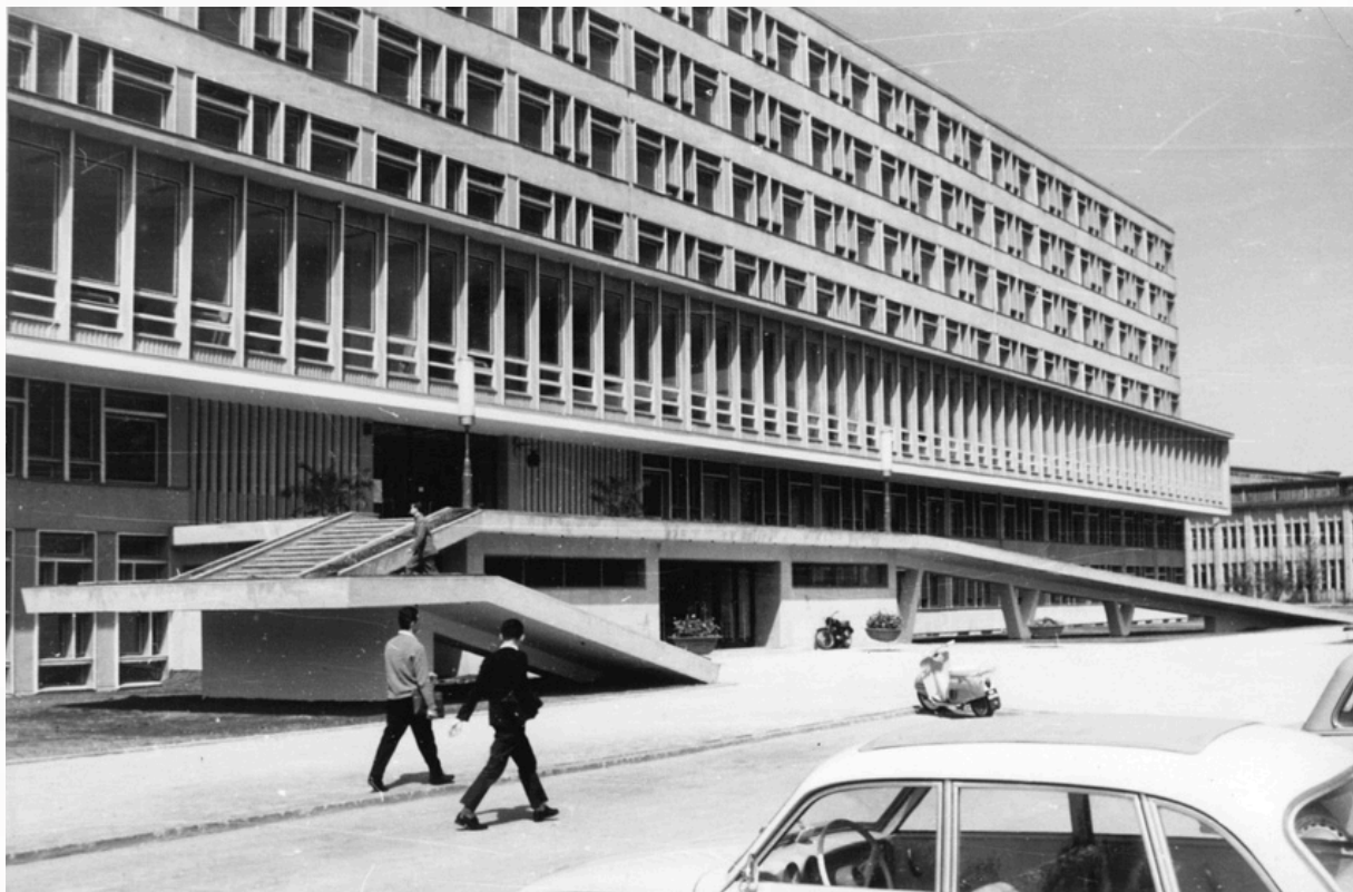
Rytm pięter i okien. Funkcjonalizm w architekturze
